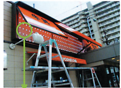
▲設置工事の様子
